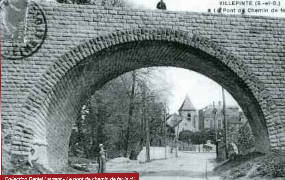
Collection Daniel Laurent - Le pont de chemin de fer (s.d.)
