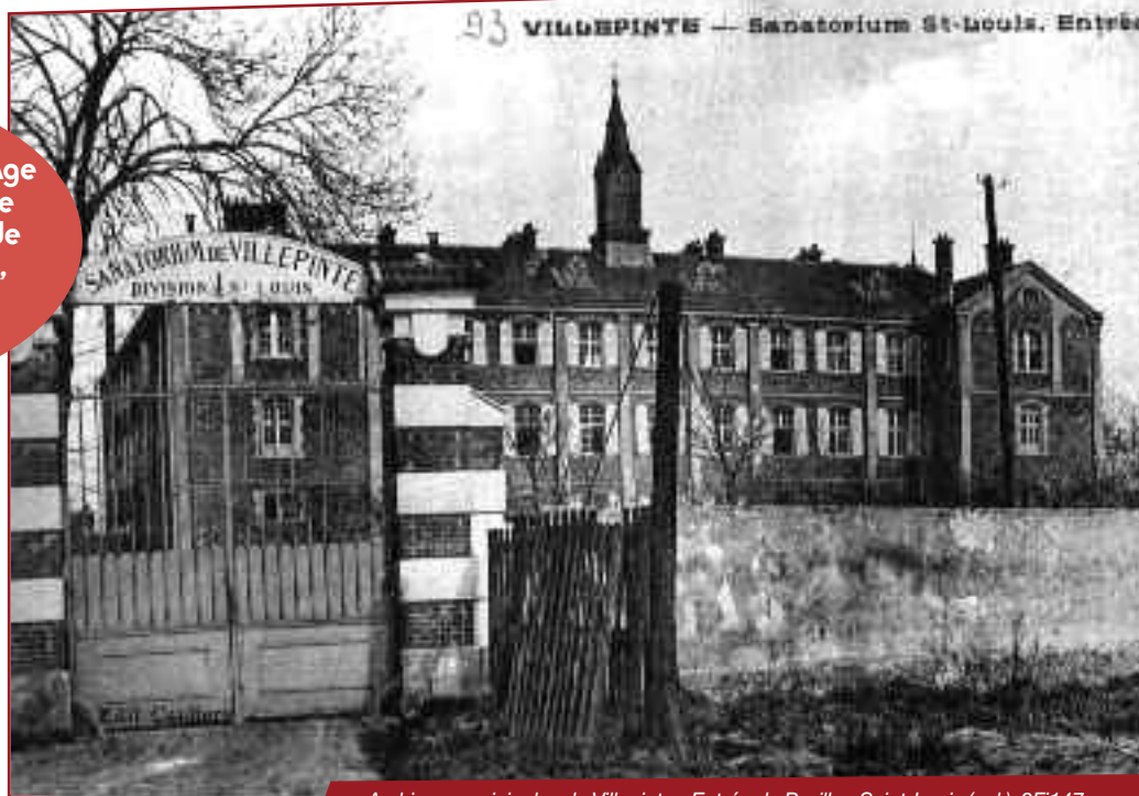
Archives municipales de Villepinte - Entrée du Pavillon Saint-Louis (s.d.), 2Fi147
